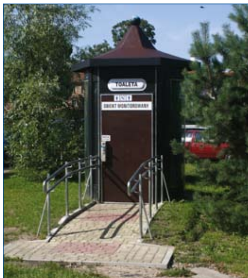
Fot. 12. Toaleta publiczna Mrągowie. W tym przypadku osoby poruszające się na wózkach inwalidzkich mają utrudniony dojazd oraz mogą mieć kłopoty z otwarciem drzwi przez zbyt blisko zamontowane poręcze (zdj. M. Wysocki).
