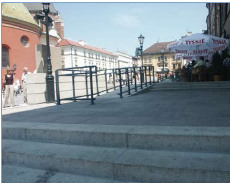
Fot. 3. Modernizacja Małego Rynku w Krakowie. Pochylnie prowadzą bezpośrednio na schody od ulicy Siennej (zdj. M. Wysocki).
