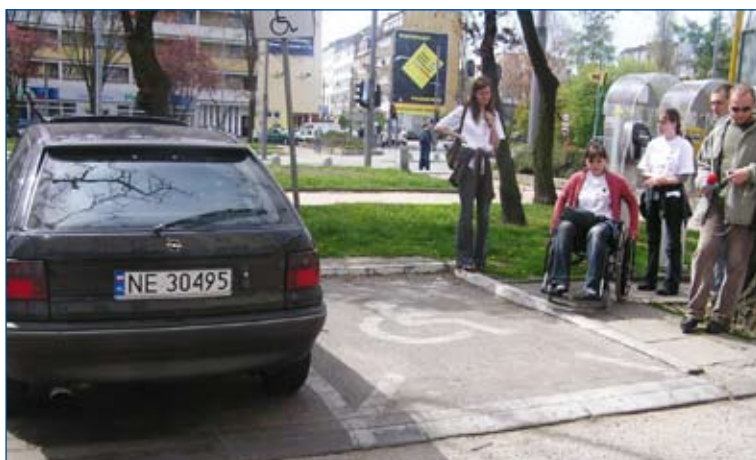
Fot. 7. Miejsce postojowe odpowiednio oznakowane, ale nie spełniające standardów dostępności dla niepełnosprawnych, zbyt wąskie i bez obniżenia krawężników. Zdjęcie wykonane w Gdyni podczas warsztów studenckich „Miasta bez barier” (zdj. A. Bąk).
