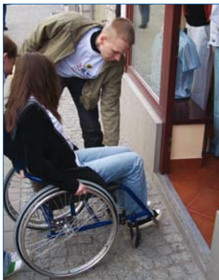
Fot. 8. Progi, które mają wysokość większą niż 2 cm są barierą architektoniczną dla osób poruszających się na wózkach. Zdjęcie wykonane w Gdyni podczas warsztów studenckich „Miasta bez barier” (zdj. P. Folwarski).
