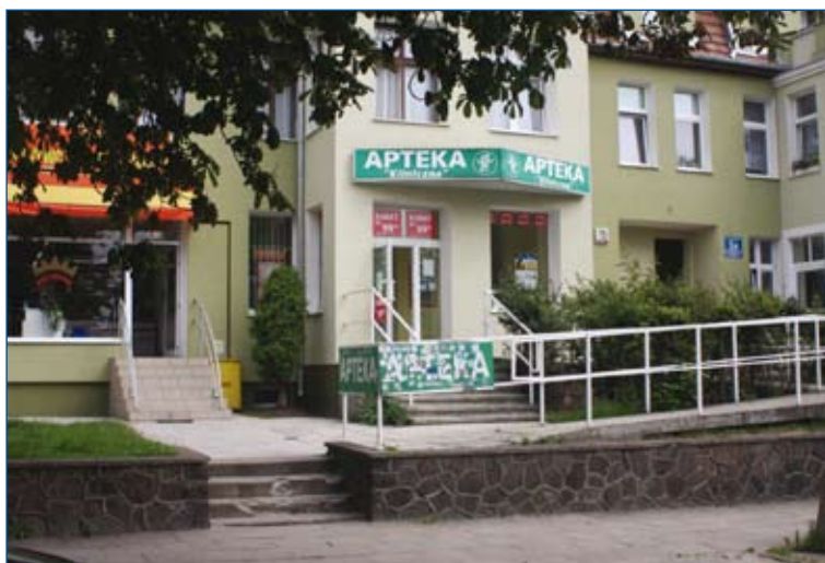
Fot. 4. Zdjęcie ukazuje bezsensowność wykonania pochylni dla niepełnosprawnych przed apteką w Gdańsku. Przed pochylnią znajdują się trzy stopnie, które są barierą nie do pokonania przez osobę poruszającą się na wózku (zdj. M. Wysocki).
